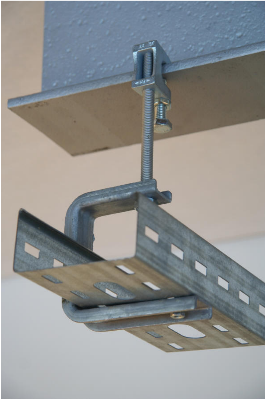
Fig.9: Kabelbakke monteret på ståldrager ved anvendelse af TKN beslag, ophæng type Z og gevindstang. Indvendigt ophæng type I kan monteres på tilsvarende måde.
