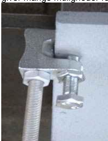
Eksempel.: TKN10M monteret på drager, koblet til gevindstang type GE.
