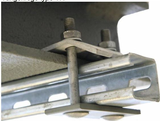
Eksempel 2.: 50V vægskinnne vendt 90 grader monteret i Ståldrager med stålbjælkebeslaget SBBS
