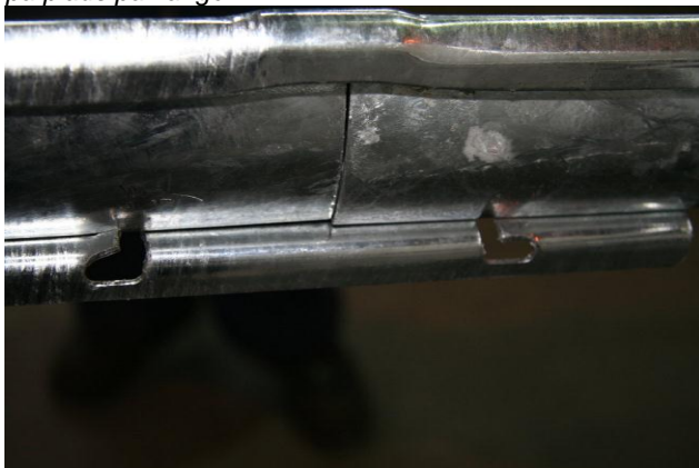
Fig. 6.: Lasken er nu låst. Låsefligene kan løsnes igen ved at vejle modsat med sømmet, eller ved at slå låsefligen nedad.
