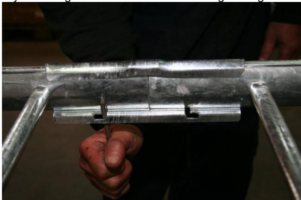
Fig. 3.: Sømmet placeres i lasken ved låsefligen.
