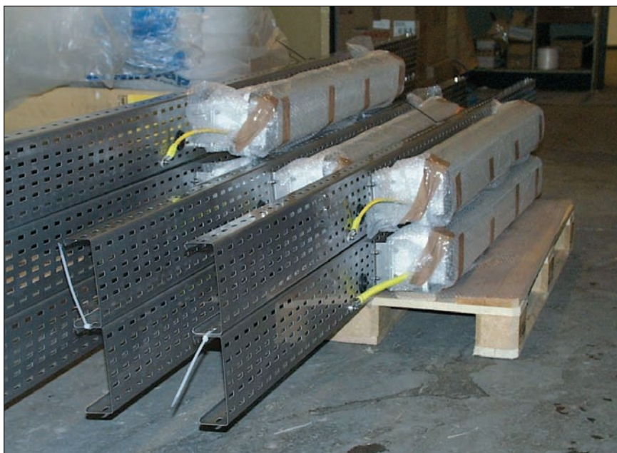
Kabelbakker monteret med kabler, lasker og armaturer, klar til at køre ind og sætte op i Øresundstunnelen.
