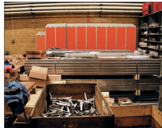
I forgrunden specialkonsoller som (for at spare montagetid on site) monteres på vægskinner inden de sættes op i tunnelen. I baggrunden delvis færdigmonterede armaturer på kabelbakker.
