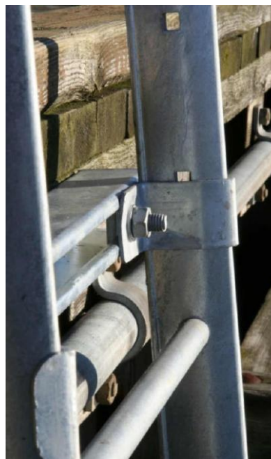
Fig.2.: Stigen monteret på 50V skinne med VVIB beslag. Beslagene er monteret med T-bolte.
