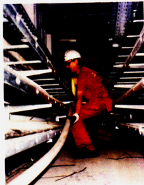
Montøren måler afstanden, hvorefter materialeforbruget computerberegnes.
