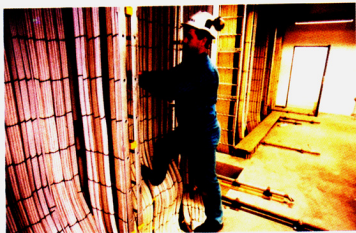
Montering af kabler i Würths kabelstiger.
