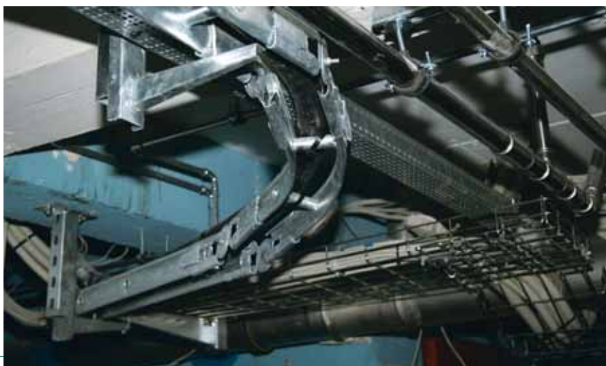
Kraftigt hovedkabel i 100 mm KS kabelstige sniges ind i bestående installation ved hjælp af formstykker og knæklasker under ombygning i Kødbyen.
